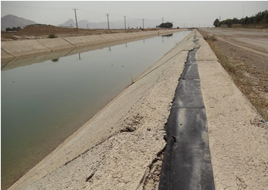
شکل ۱. محافظت از ژئوممبران با بتن‌ریزی در شبکه آبیاری نکوآباد اصفهان
