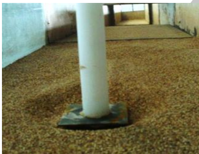
شکل ۵. نمایی از طوق استفاده شده و گودال آبخستگی ایجاد شده
