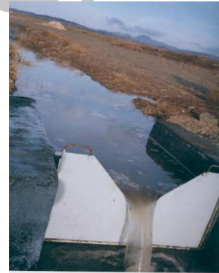
شکل ۹- سرریز مثلثی بر روی کانال مسیر ۲
