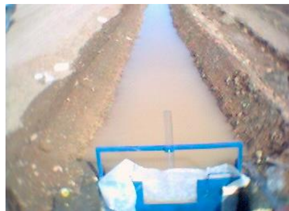
شکل ۱۴- آزمایش برکه در پشت دریچه‌ها
