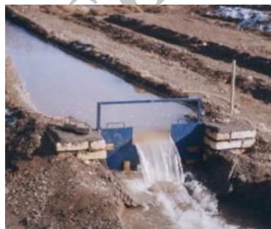
شکل ۲- سرریزهای نصب‌شده بر روی کانال‌های آزمایشی مسیر ۱ و ۲
