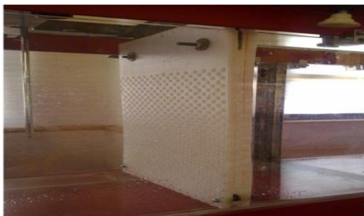
شکل ۲- صفحه مشبک نصب‌شده روی فلوم
