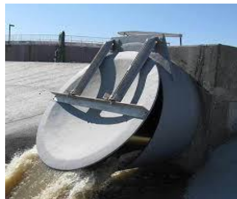
شکل ۳- نمونه دریچه آویخته با مقطع دایره‌ای در انتهای یک مجرا
