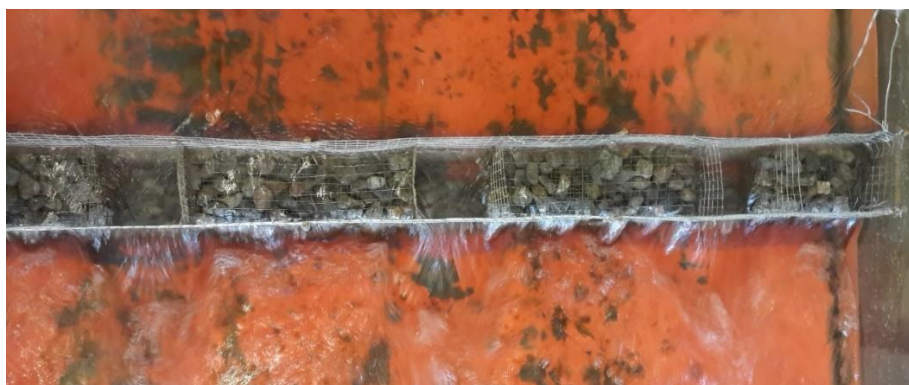
شکل ۴- نمایی از آب‌پایه تورسنگی و ایجاد بازشدگی در آن
