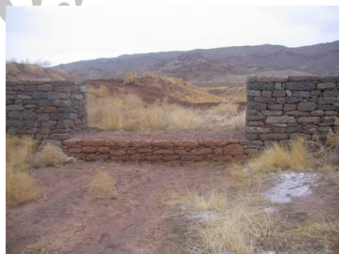
شکل ۴- نمای پایین دست یکی از بندهای توری سنگی که به دلیل کم بودن فاصله با بند بعدی حوضچه آرامش آن در رسوبات سد پایین دست دفن شده است.
