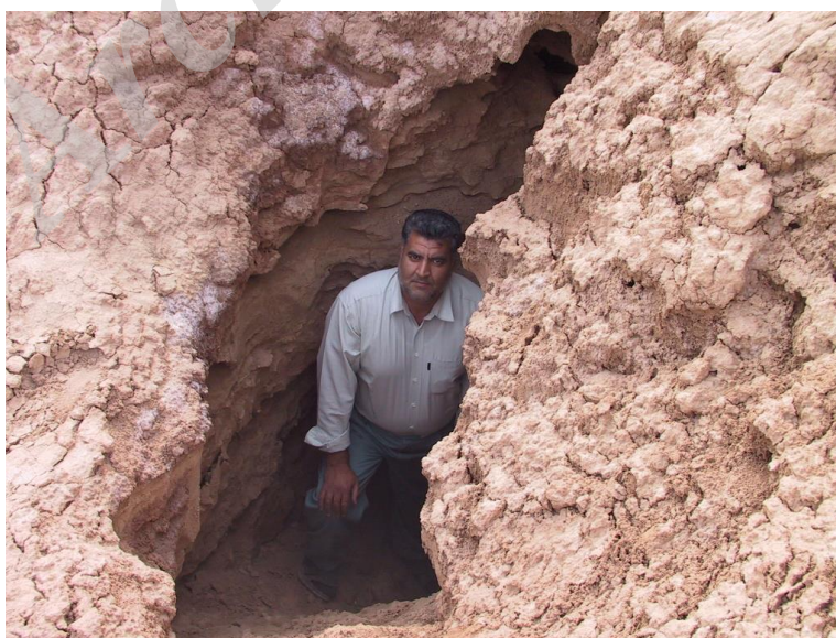
شکل ۲- واحد M3 با فرسایش تونلی شدید در جنوب شرق ورامین، کوه سرخ
