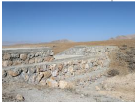
شکل (2): نمایی از سازه احداث شده در منطقه
