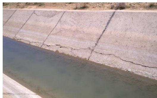
شکل(۱): نمونه‌ای از شکستگی‌های ناشی از تورم در کانال‌های موجود در شبکه آبیاری سورک
