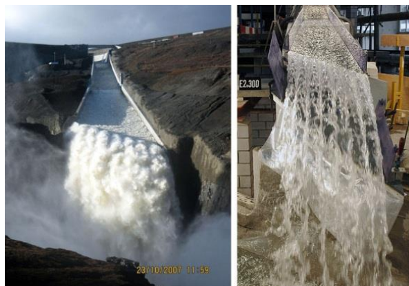
شکل (۲): سرریز سد Kárahnjúkar در کنار مدل هیدرولیکی آن
