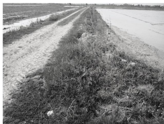
شکل (۴): نمونه‌ای از مشکلات به وجود آمده در دوران بهره‌برداری از پروژه‌ها: شرایط نامناسب و عدم استفاده از کانال‌های آبیاری احداث شده در پروژه عرب خیل (سمت راست)، استفاده از زهکش برای آبیاری با ایجاد بندهای موقت در پروژه اسماعیل کلا (سمت چپ)
