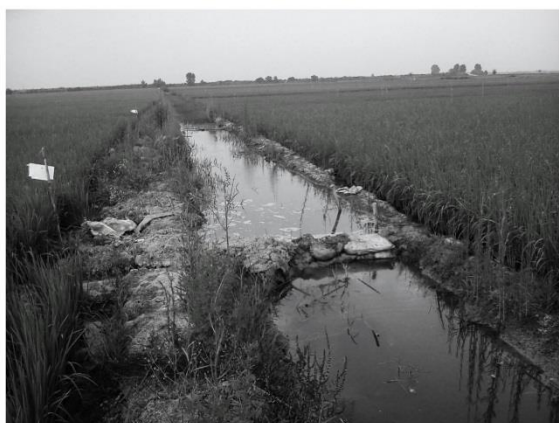
شکل (۴): نمونه‌ای از مشکلات به وجود آمده در دوران بهره‌برداری از پروژه‌ها: شرایط نامناسب و عدم استفاده از کانال‌های آبیاری احداث شده در پروژه عرب خیل (سمت راست)، استفاده از زهکش برای آبیاری با ایجاد بندهای موقت در پروژه اسماعیل کلا (سمت چپ)
