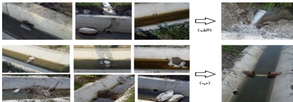
شکل ۸- مقایسه ساختار آگیری و کنترل در ساختار فعلی (سمت چپ) و بهبود یافته (سمت راست): الف) لوله های آگیری ورودی کرت، ب) کنترل سنتی آب در کانال و ایجاد بند سرریز کنترل در بهبود سیستم
