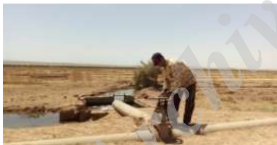
شکل (۵): دو نمونه از چاه‌های عمیق دشت صفی آباد
