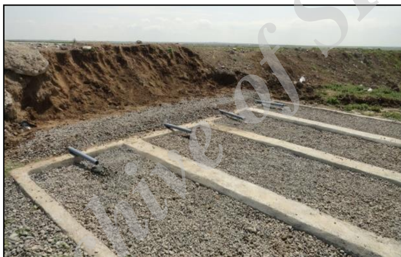
شکل ۲- لوله‌کشی و جریان زهاب به حوضچه‌ها
