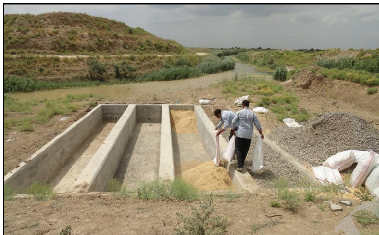
شکل ۱- پر کردن حوضچه‌ها با فیلتر (سبوس برنج)
