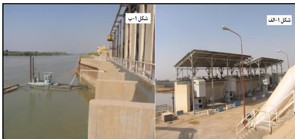
شکل ۱- الف) نمایی از ایستگاه پمپاژ ویس، استان خوزستان و ب) لایروبی دهانه آگیری به دلیل رسوب‌گذاری ورودی دریچه‌های آگیری
