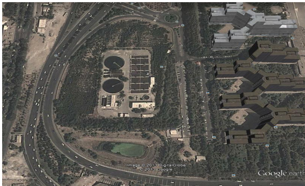
شکل ۱- نمایی از تصفیه‌خانه شهرک اکباتان
