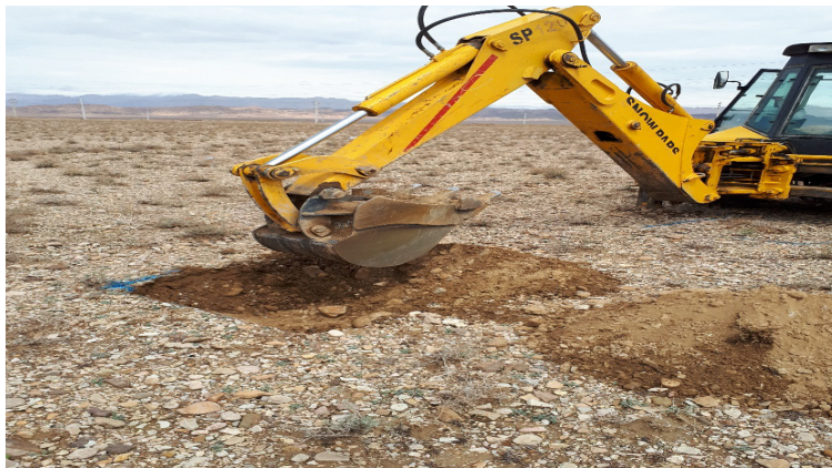
شکل ۲- حفر گودال توسط بیل مکانیکی به منظور قرار دادن تشت تبخیر کلرادو
