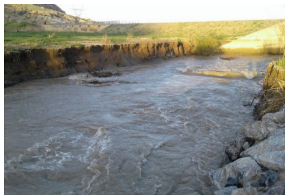
شکل ۶- فرسایش کناری در بستر رودخانه
