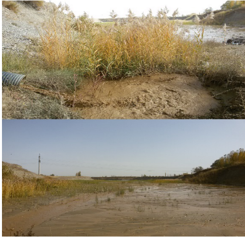
شکل ۷- سد رسوب‌گیر پساب کارگاه ماسه‌شویی نازلوچای
