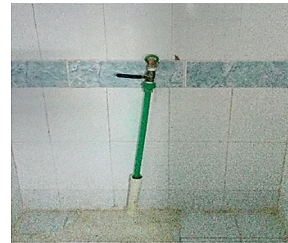
شکل ۴- تصویری از نامناسب بودن سیفون ها در خوابگاه
