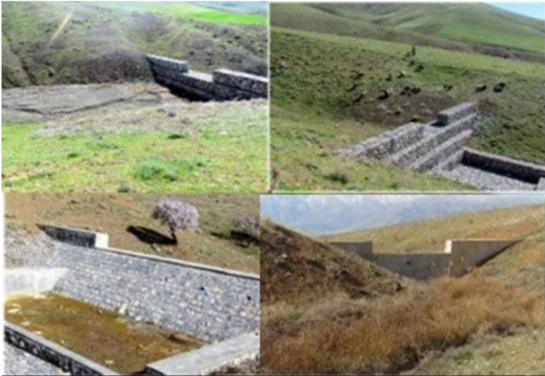
شکل (۴): نمونه بندهای رسوب‌گیر سنگی ملاتی و گابیونی در محدوده آبراهه‌های روستای قشلاق حوضه رزین
