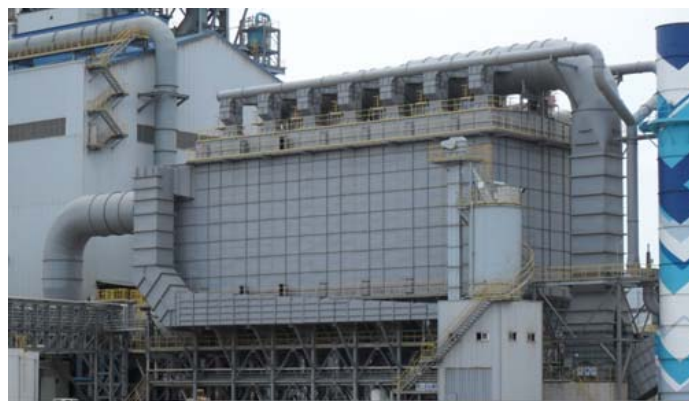
شکل ۳. واحد پاکسازی گاز از ذرات معلق که از طریق فیلتر الکترواستاتیک انجام می‌شود.
