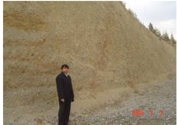
شکل ۱- آبرفتهای سازند A در شمال بزرگراه شهید همت، شیبدار بودن لایه ها و پایدار بودن دیواره های قائم بدلیل چسبندگی بالا در این شکل نشان داده شده است (زمستان ۱۳۸۳).
