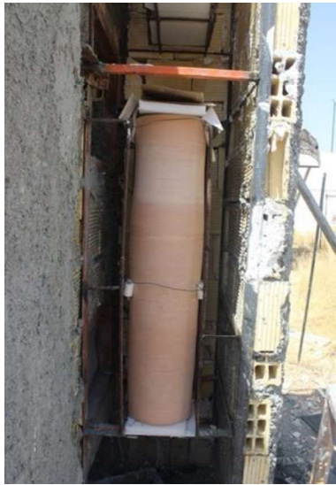
شکل (۲-ب). دو استوانه نصب شده در پایین کانال بادگیر (منبع: نگارندگان)
