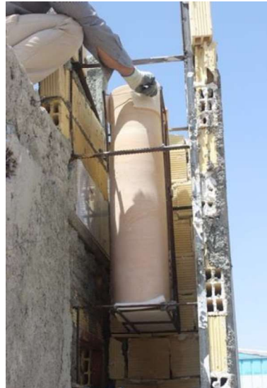
شکل (۲-الف). دو استوانه نصب شده در بالای کانال بادگیر (منبع: نگارندگان)
