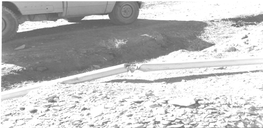
شکل ۱- تأثیر مخرب باد شدید بر لوله‌های سیستم آبیاری بارانی رول‌لاین.
