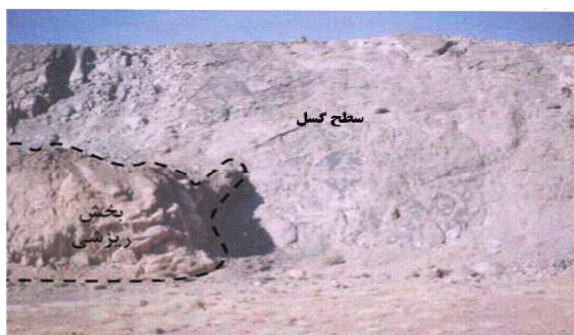
شکل ۶ بخش ریزشی و سطح گسل موجود در منطقه.
