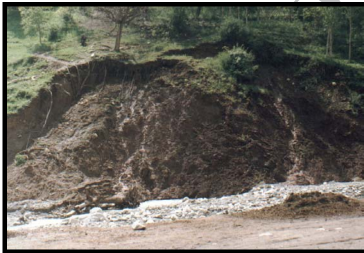
شکل ۱۳- سیالی شدن رسوبات تراس کناری رودخانه عیش آبادچای (اردیبهشت ۱۳۸۳)
