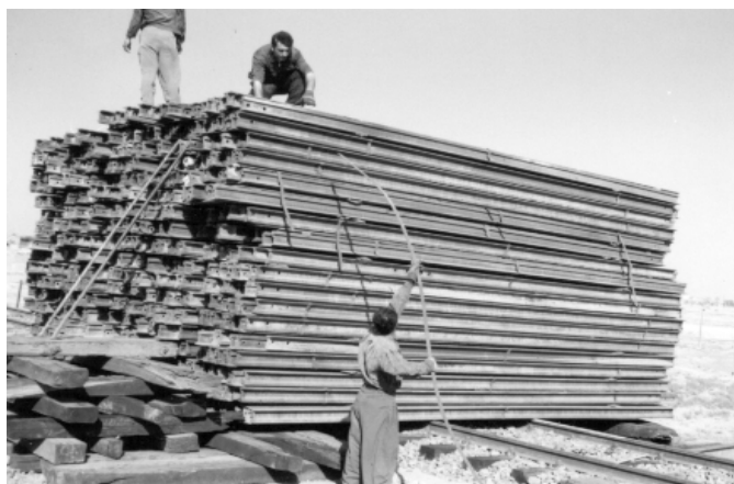
شکل ۶: بارگذاری استاتیک پل بوسیلهٔ وزنه‌های بتنی ساخته شده از ریل‌های فرسوده.
