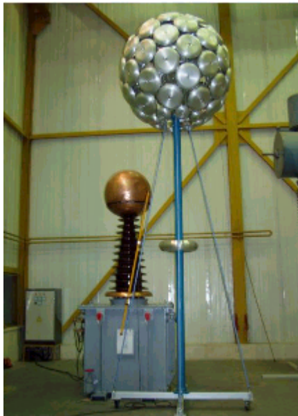
شکل ۴- ب: ترانسفورماتور آزمایشگاهی فشار قوی.
