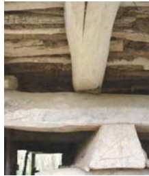
تصویر ۶- قرارگیری فک، بنه دار، کمرکش و زغال طبقه اول
