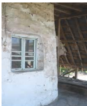
تصویر ۹- جمع شدن دیوارها به داخل
