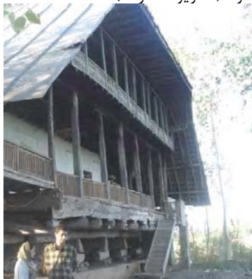
تصویر ۳- بنایی با پی شیکیلی در رودبند
