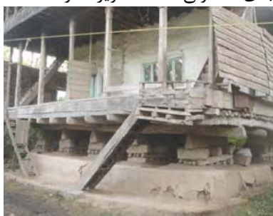
تصویر ۲- احداث پاکه برای ساخت پی
