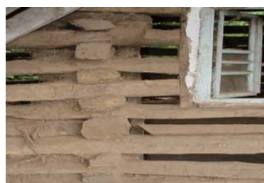
تصویر شماره ۸- قرارگیری گردبینه ها و چارچوب پنجره
