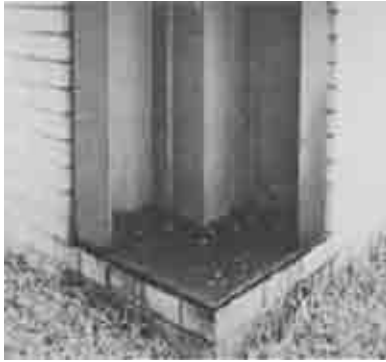
تصویر ۱۳- راه‌حل میس وندرووه برای مسئله گوشه یک ساختمان، ساختمان سیگل، شیکاگو، ۱۹۴۷. ماخذ: (www.greatbuildings.com)
