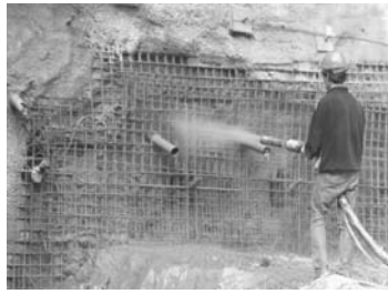
تصویر ۱۲- روش میخ کوبی - شاتکریت. (مأخذ: نگارنده)
