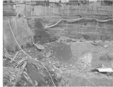
تصویر ۲۱- روش میخ کوبی - رانش پوسته بتنی و تخریب پیاده رو و تأسیسات زیر بنایی مجاور سایت. (مأخذ: نگارنده)
