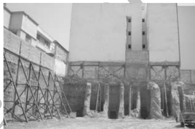
تصویر ۲- پایدار سازی جداره گودبرداری از داخل - روش خرپا، (مأخذ: نگارنده)
