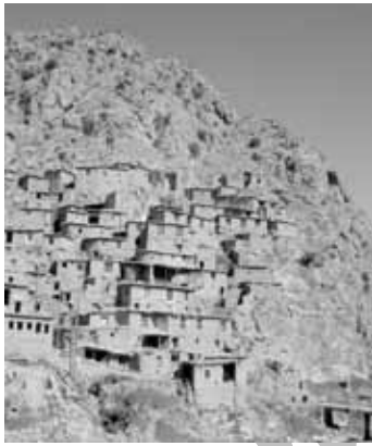
تصویر ۱۲ - بافت متراکم روستا و استفاده از سقف خانه پائینتر به عنوان حیاط خانه بالاتر - روستای پالنگان کردستان. (مأخذ: نگارندگان)
