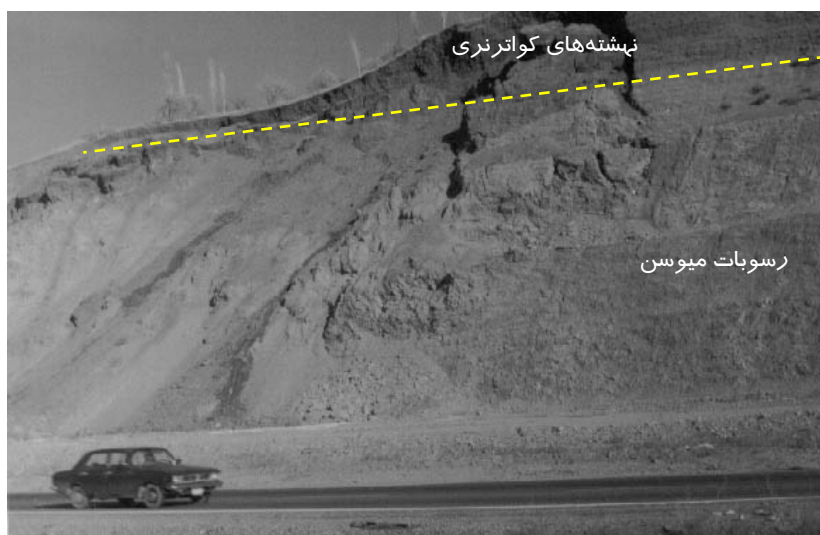
شکل ۴ ناپایداریهای حاصل از ایجاد ترانشه برای احداث باند جدید راه صوفیان-مرد
