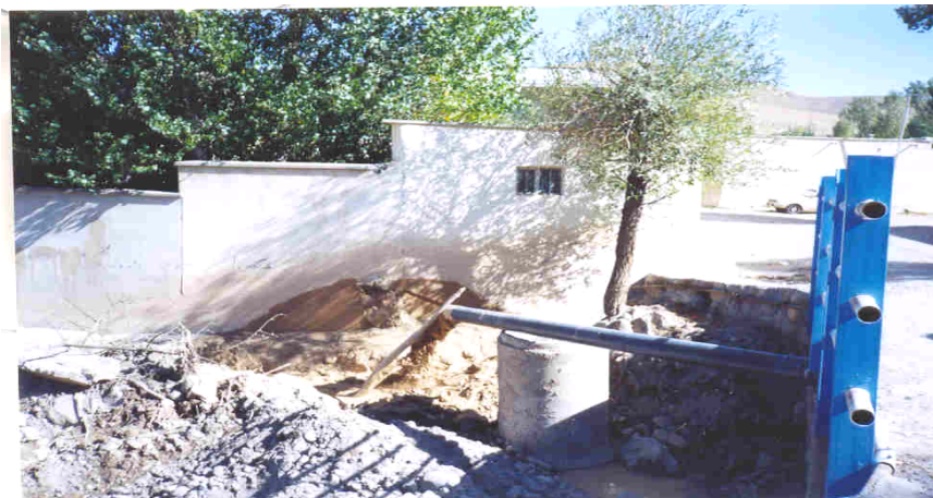
شکل ۱۲ تخلیه آبهای گل‌آلود ناشی از عملیات ماسه‌شویی به دره ليقوان (به ضخامت مواد نهشته شده دقت شود)
