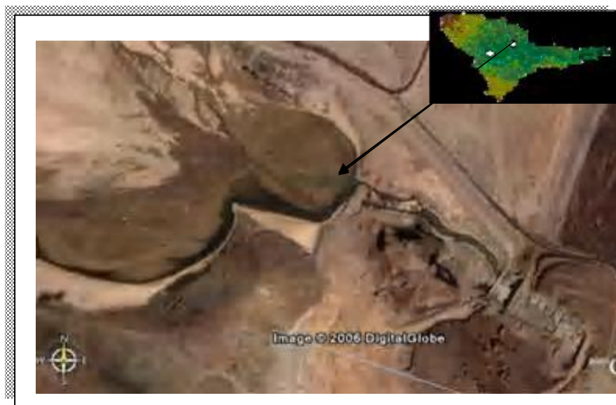
شکل 10: سد بزرگ سهند در حوضه قرنقوچای، که در حال آبرگیری است ( www.earthgoogle.com )
