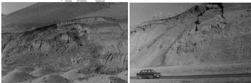
شکل ۲: ناپایداری دامنه بر اثر خاکبرداری از پایکوه به منظور جاده سازی، راست: سه راهی
