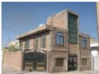
شکل (۶) نمایی از ساختمان‌های آجری شناژدار (واحد ۴)
