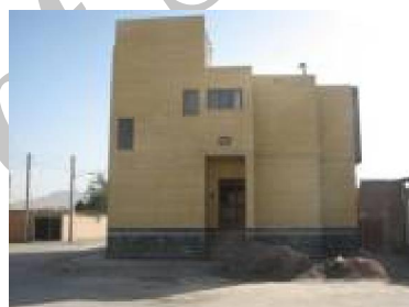
شکل (۷) نمایی از ساختمان‌های اسکلت فلزی (واحد ۵)
