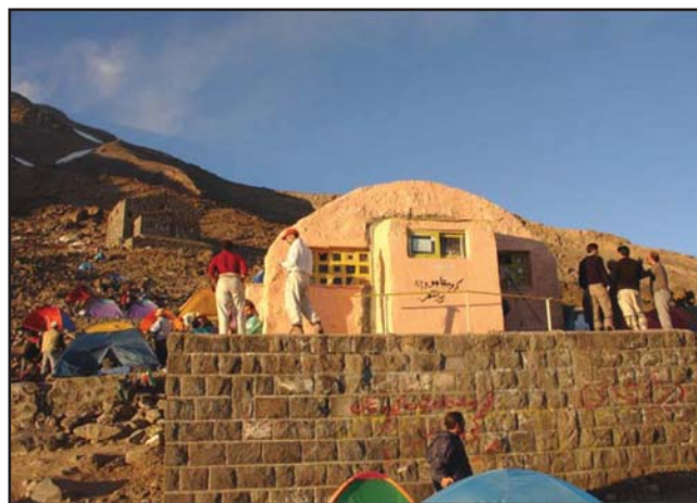
شکل ۱۵- پناهگاه بارگاه سوم در ارتفاع ۴۲۰۰ متری در دامنه جنوبی (زارعی نژاد، شهریور ۱۳۸۶)
