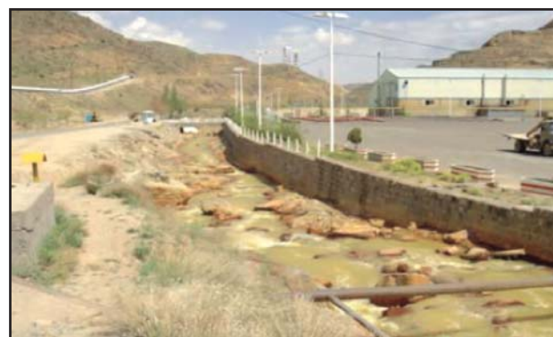
شکل ۱۰- زهاب خروجی از معدن، کدر و حاوی ذرات معلق آهن نبود جلبک‌ها
