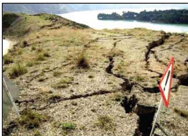
شکل ۸- ایجاد ترک های کششی در دامنه مشرف به سد (جهت دید شمال باختری) (رضایی، ۱۳۸۵)
