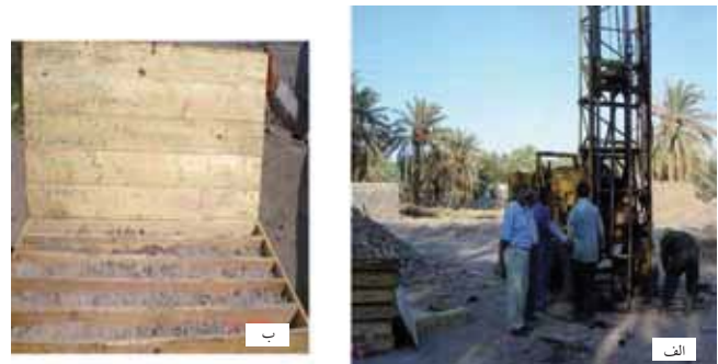
شکل ۵- نمایی از الف) محل حفاری وب) مغزه‌گیری در ساختمانه مورد مطالعه
