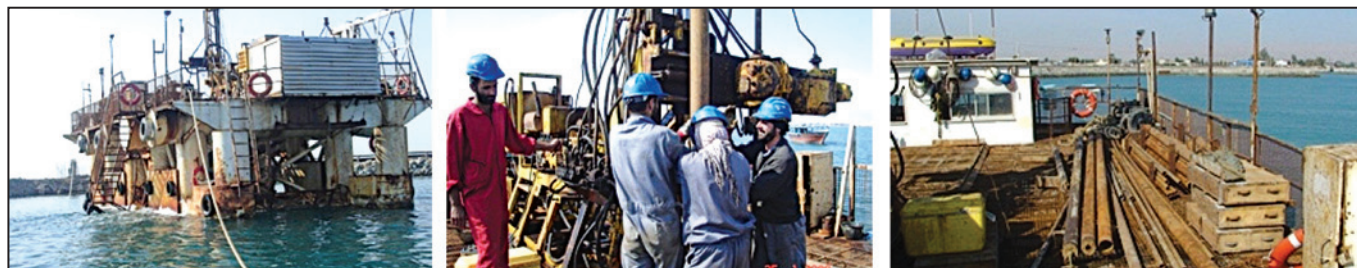
شکل ۳- دستگاه حفاری و مغزه‌گیری از رسوبات بستر دریا.
