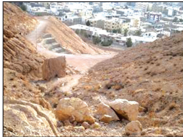
شکل ۴- واریزهای موجود روی دامنه مشرف بر مناطق مسکونی.
