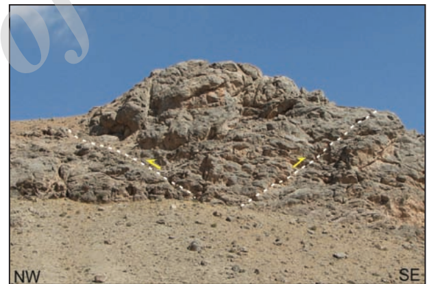
شکل ۱۴- رخنمون صفحه گسله F_8 در معدن سنگ آهک کارخانه سیمان شهرکرد در واحد K_3 ؛ ب) سطوح خش سطح گسل F_8 ؛ استریوگرام گویای گسلش عادی است (موقعیت این برداشت در نقشه زمین‌شناسی گستره مورد مطالعه در شکل ۲ مشخص شده است).
