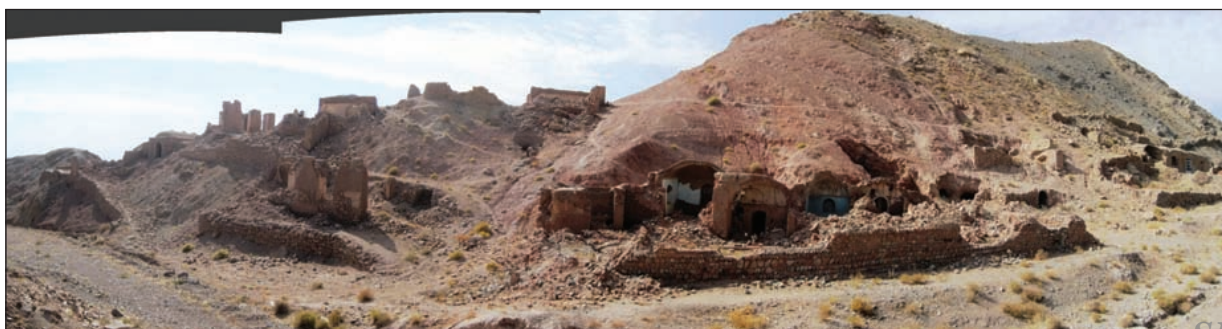
شکل ۱۳- نمایی از امتداد گسل کوهبنان در روستای داهویه که دقیقاً خانه سازی در هسته گسل ساخته شده است.
