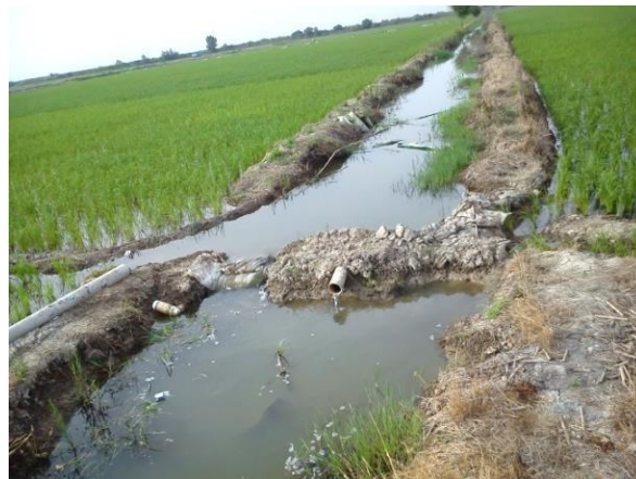
شکل ۳. ایجاد بند و آبیگری از زهکش های طرح در کرت های انتهایی، پروژه تجهیز و نوسازی اراضی اسماعیل کلا، جویبار، مازندران
