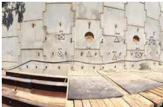
شکل ۱۲. مقاومت‌سازی دیوار نگهدارنده خاک با استفاده از روش بیوکلیسیس در مقیاس میدانی (۸)
