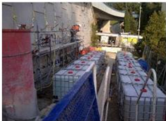
شکل ۱۲. مقاومت‌سازی دیوار نگهدارنده خاک با استفاده از روش بیوکلیسیس در مقیاس میدانی (۸)
