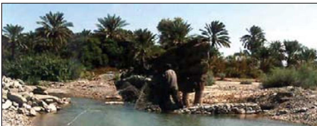
تصویر ۶: نمایی از آبشستگی ایجاد شده در آب شکن‌های شمع کوبی و توربستگ در حال احداث به ارتفاع یک متر در زیر آب شکن (۱۳۷۶)
