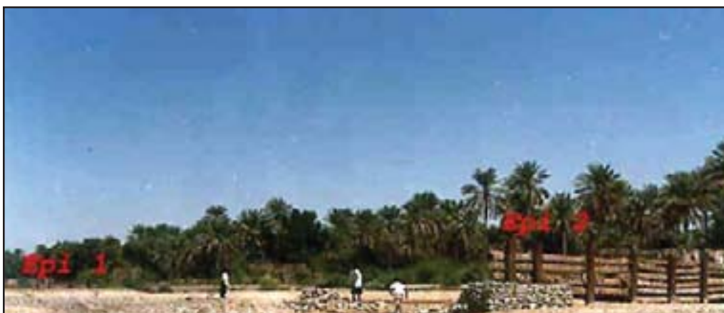
تصویر ۳: نمایی از آب شکن شماره ۲۰ شمع کوبی و روسوبگذاری بین دو آب شکن که دارای ضخامت کمی بوده و بسمت آب شکن
