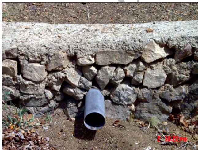
عکس ۳- اندازه گیری نشت از پشت دیوار بند دره مرید
